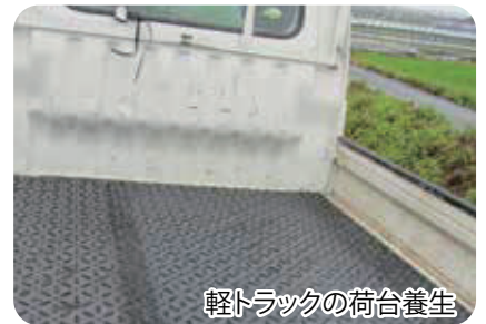
ビニールハウス出入口養生
