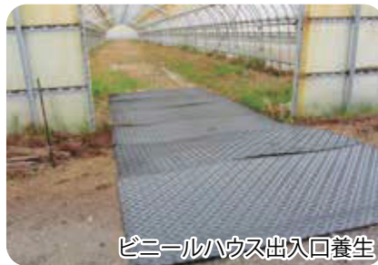
農機走行の路面養生
